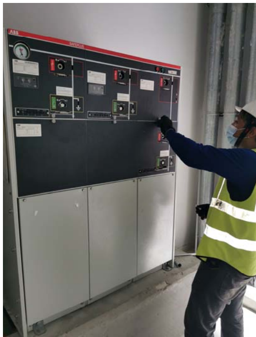
Photo 3-4-5-6-7 : ภาพของการตัดระบบไฟฟ้าและตรวจสอบ RMU ขณะทำ Preventive Maintenance
